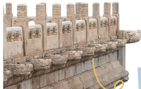
太和殿廣場設有小排水孔，例如高台建築欄板下的小孔和螭首（上古神話傳說中的一種龍）排水孔，下暴雨能迅速把雨水排走。
