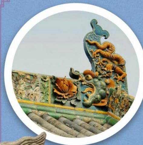
在古代建築中，人們懂得在建築物的屋頂、飛簷上雕有像龍一樣的琉璃瓦小動物，稱「正吻」，它不僅是克火神靈的象徵，還是防止雷電火的實用工具，作用與現代避雷針相似。正吻觸雷後，其電流便沿正吻內的雷公柱、太平樑、角樑、沿柱等引向地面。
