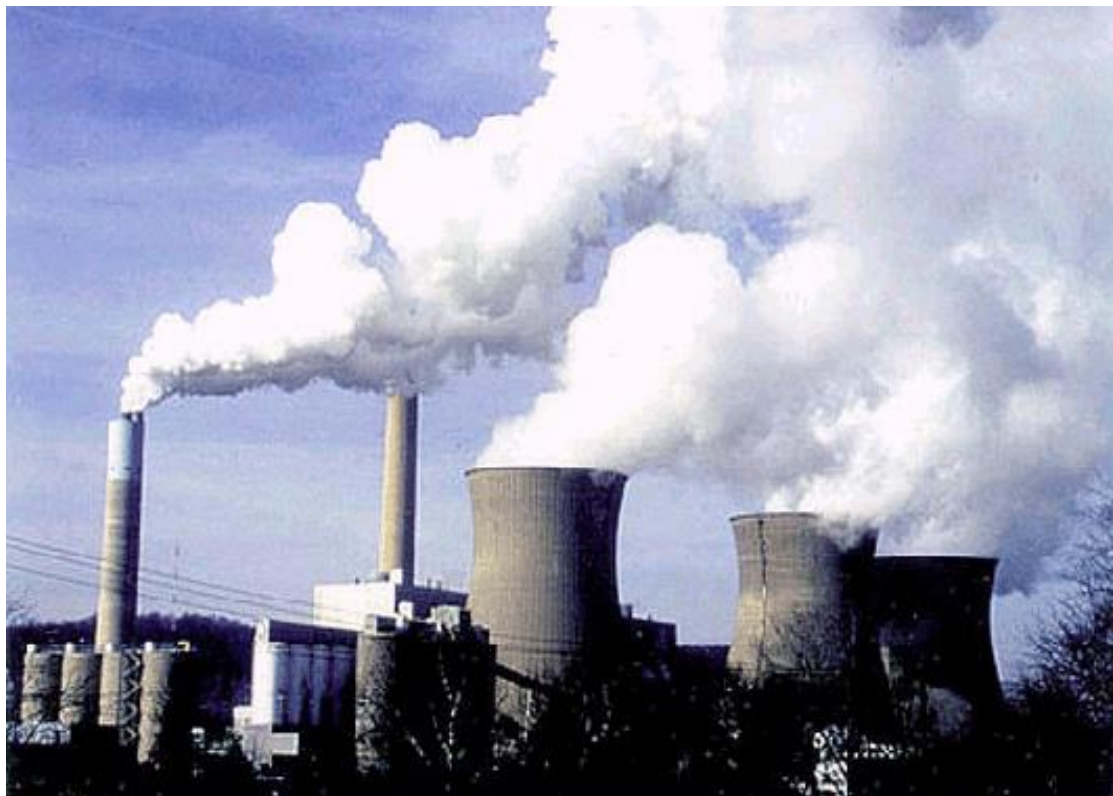
煙囪排出大量廢煙塵
