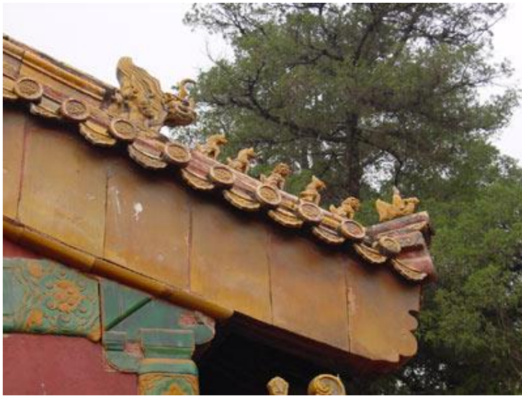
吻兽的多少显示了该建筑的尊卑
