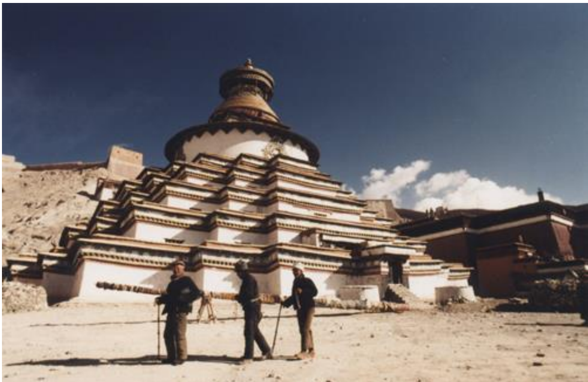
西藏江孜萬佛塔的塔廟建築
