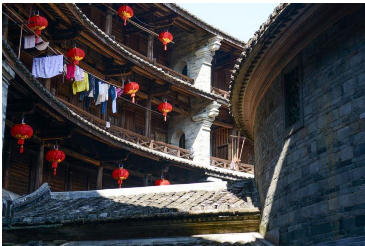
振成楼内部建筑
