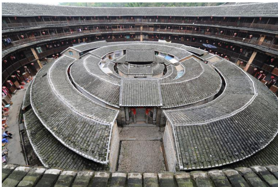
土楼的建筑设计精美
