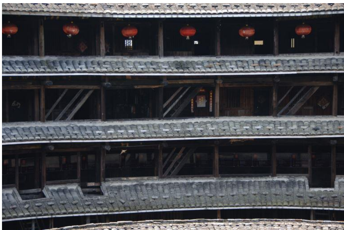
集庆楼内有 72 条楼梯，一户一梯。
