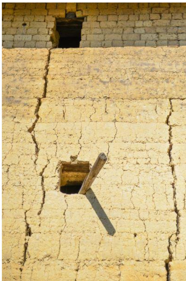
土楼运用夯土板筑技术
