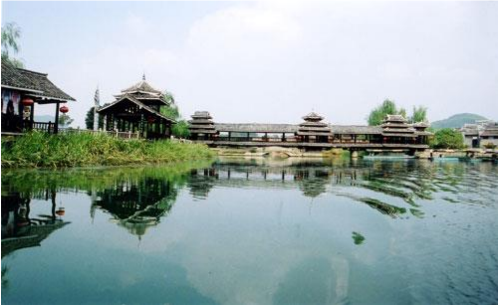
廣西壯族的風雨橋是乘涼好地方
