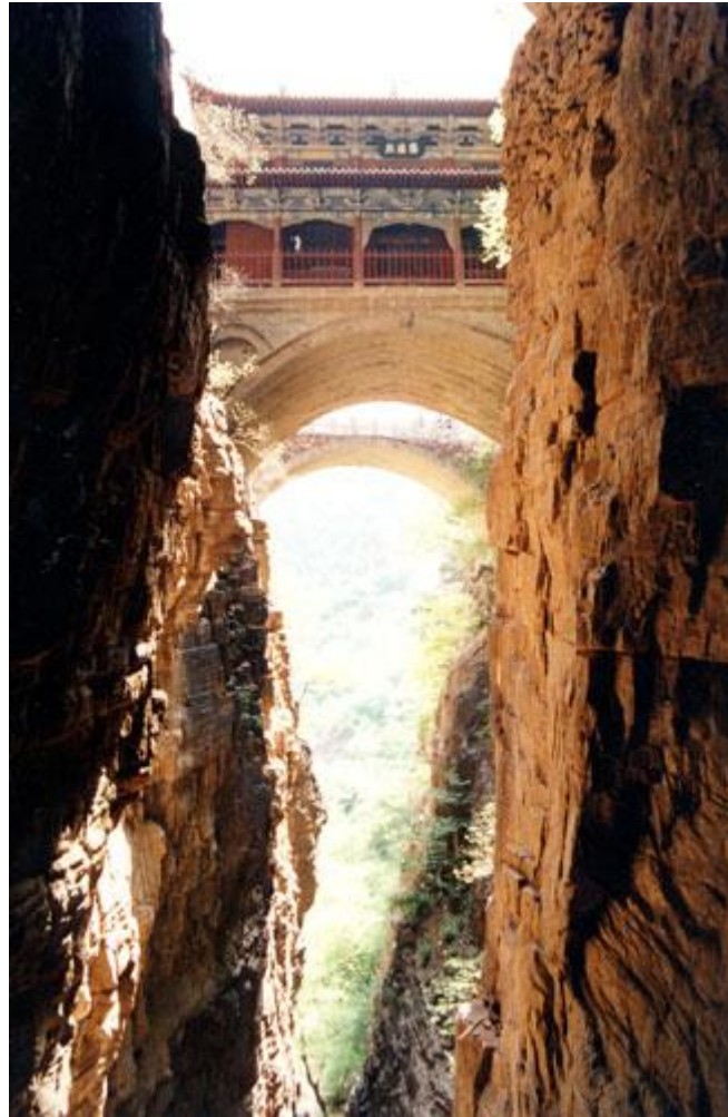
河北井陘橋樓殿
