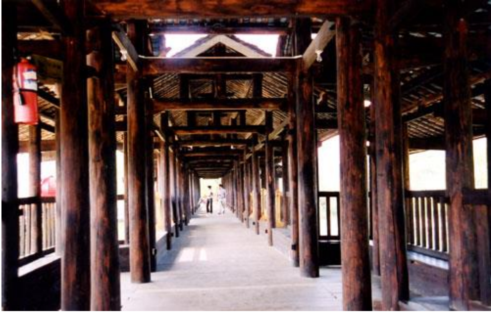
南方風雨橋橋廊構築的優美線條
