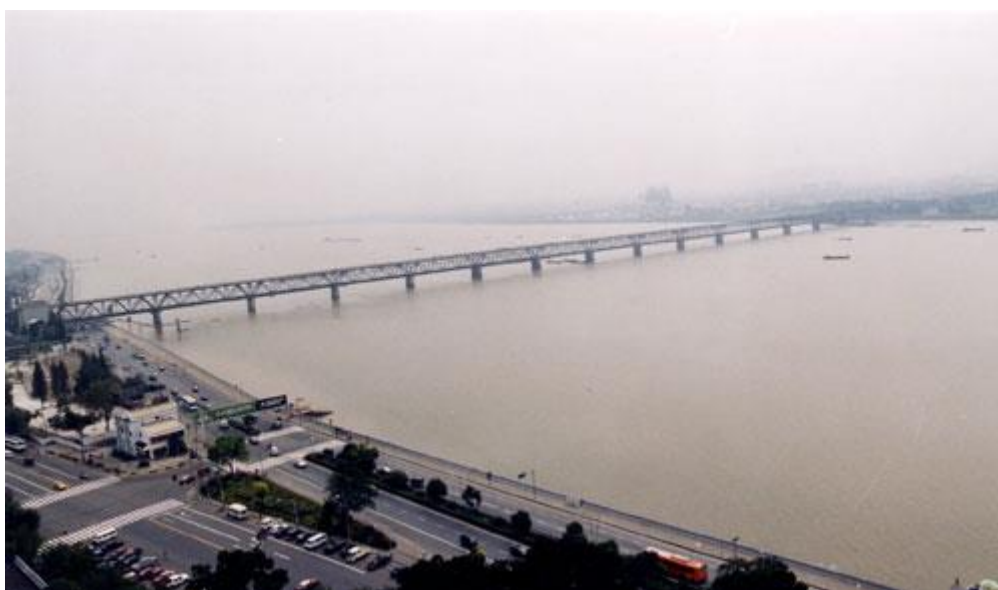
杭州錢塘江大橋
