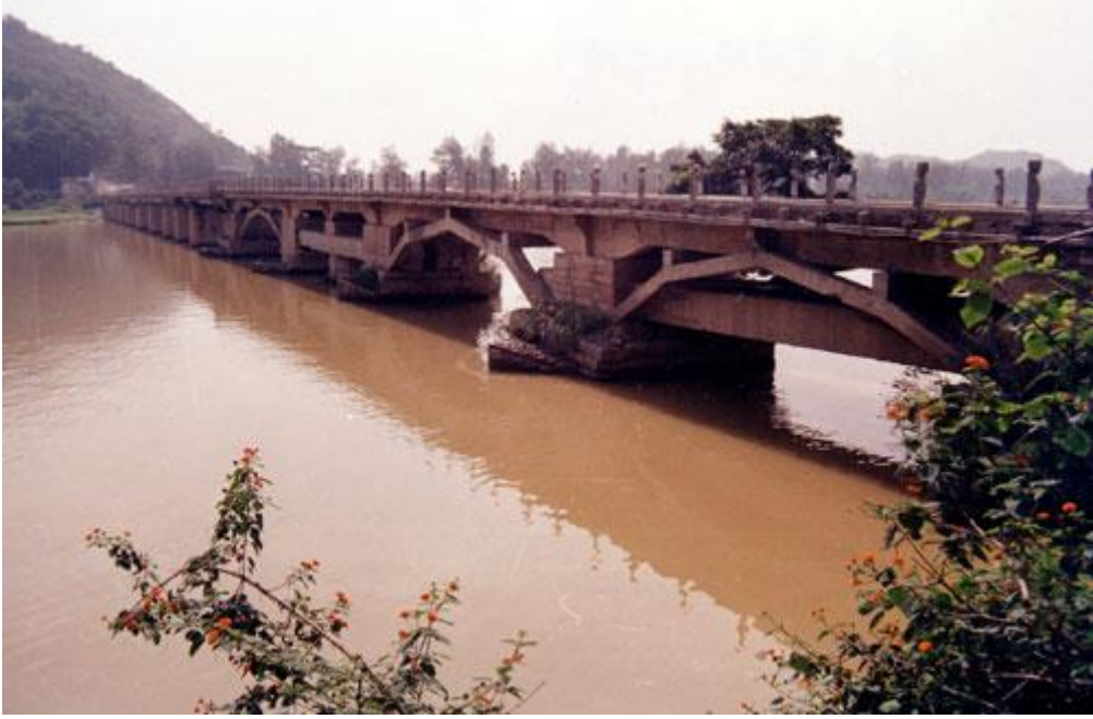
宋代在修建漳州江东桥时用了浮运法
