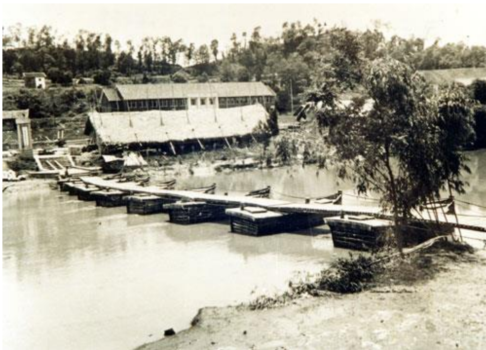
重庆打磨滩浮桥（现已不存）
