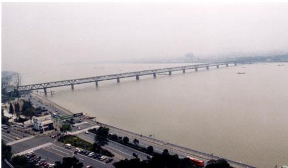
杭州钱塘江大桥
