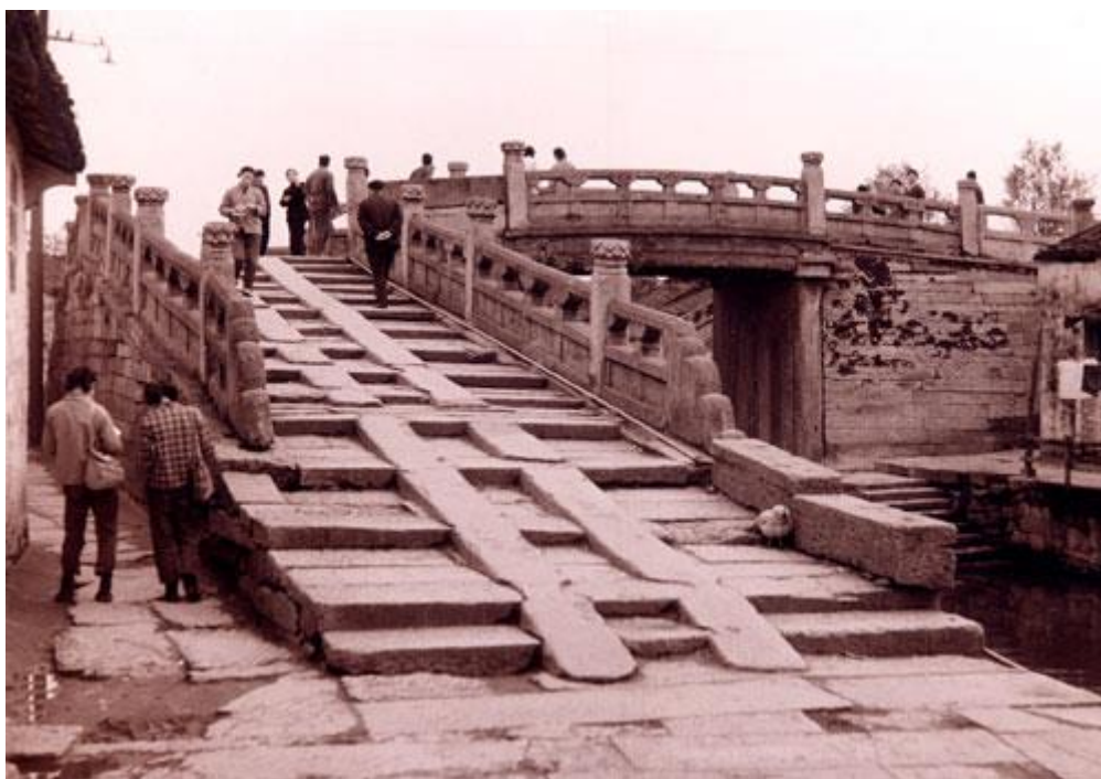
绍兴八字桥早年的面貌
