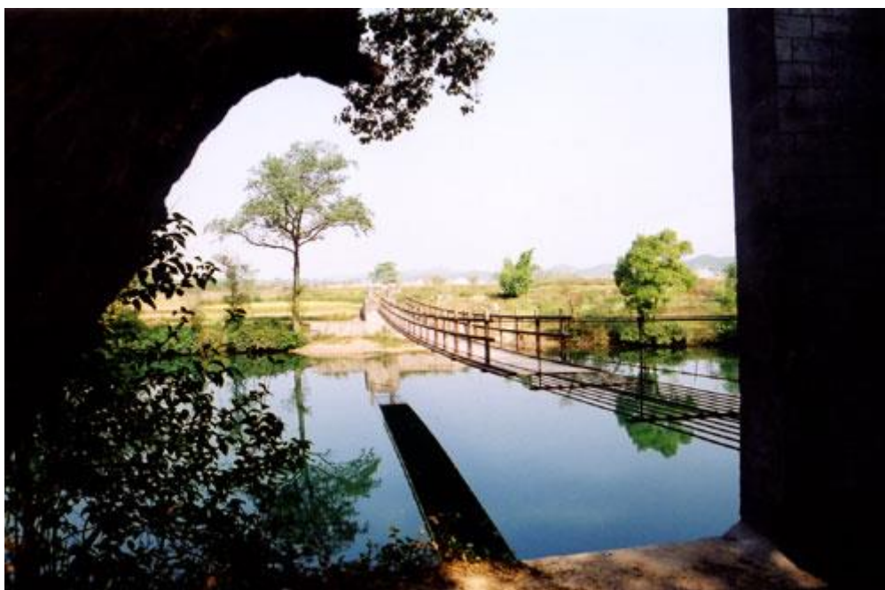
广西桂林灵渠索桥
