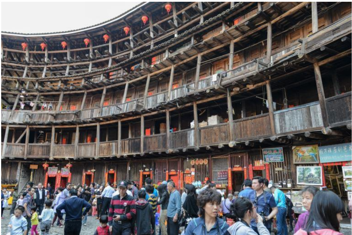
圓樓的結構營造出喧鬧的環境
