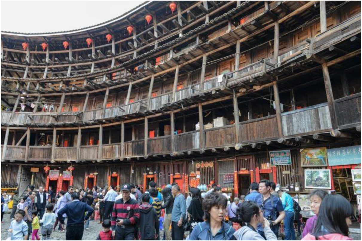
裕昌樓內的「東歪西斜」現狀
